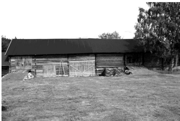
Ingrid Stenseth har nylig restaurert hele låven.
