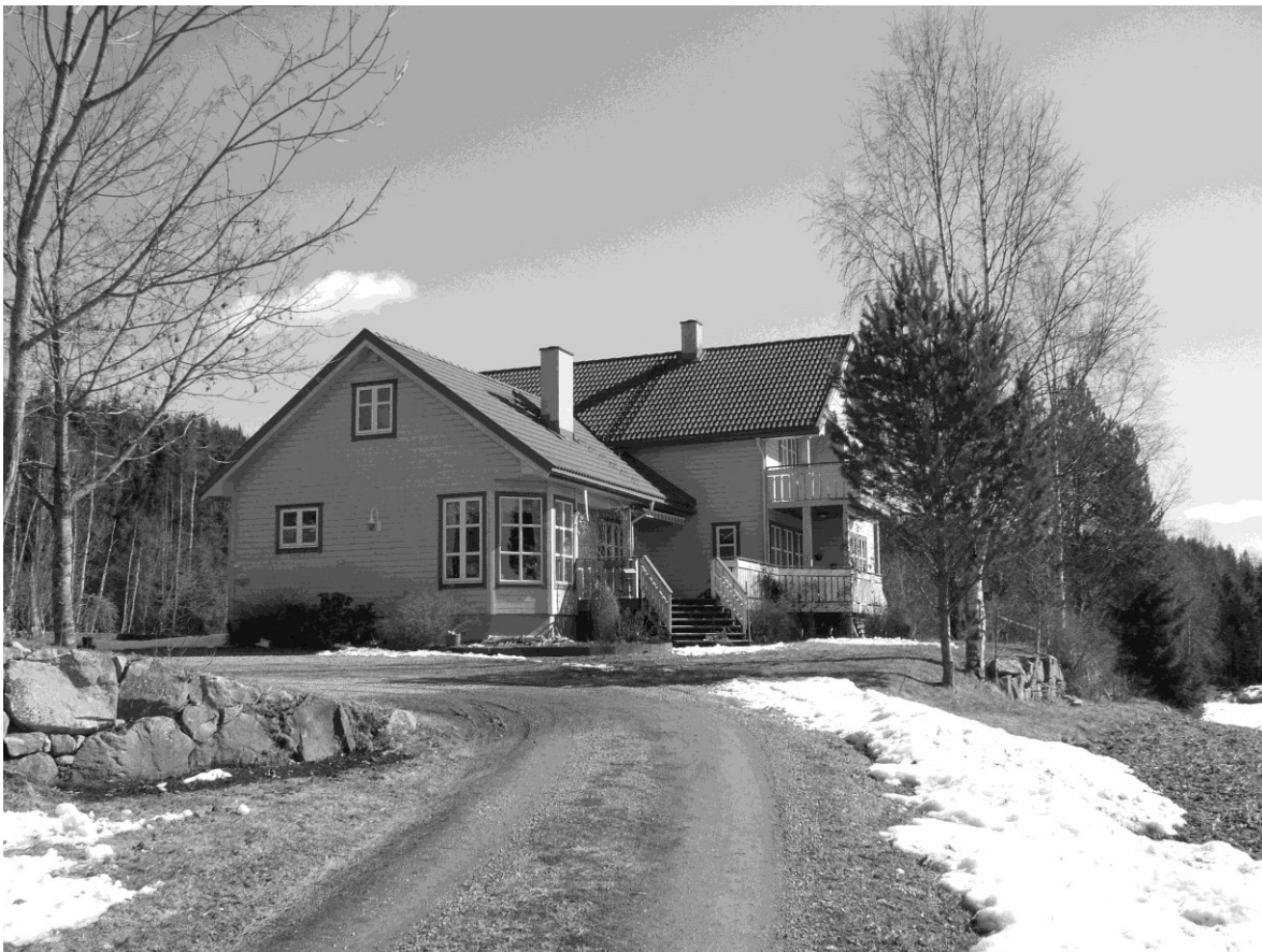
Granset-bygningen bygd i 1999. Der Reidun og Thor Grønnerud bor.
