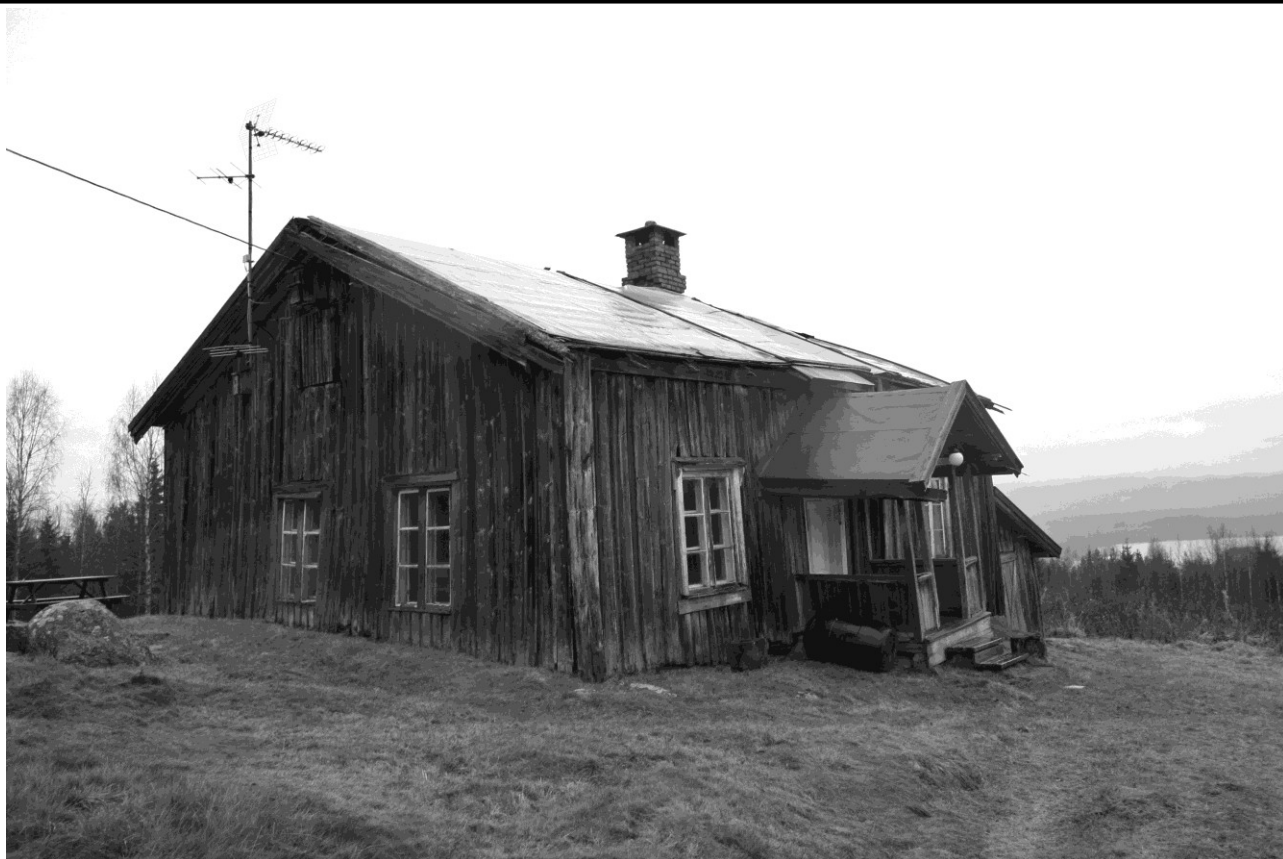
Våningshuset i Øvre Homsjørøya har i senere år fått lagt bølgeblikk på taket. Dette har hindret ytterligere forfall. Bureien sees i bakgrunnen
