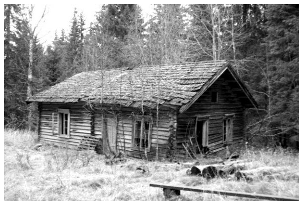
Våningshuset på Hansrud nord for Roverudsetra. Et stikktak som ikke vedlikeholdes fører til et raskt forfall.
