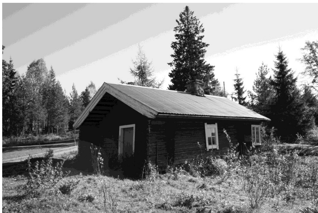
Kokhuset på Øvre Lauvhøgda reddet med et bølgeblikktak.
