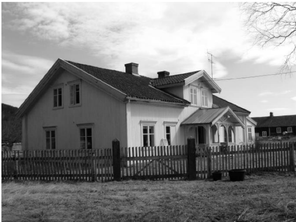
Vest-Nor sett fra nord-vest. Hovedbygning fra 1812. Foto: Ole Erik Ruud 2011
