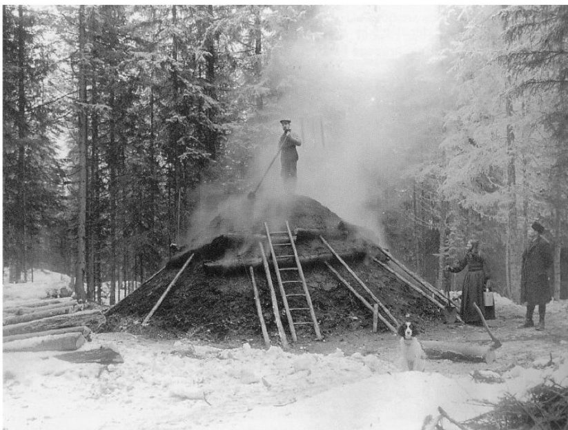
Brenning av kullmile – gammelt bilde.
