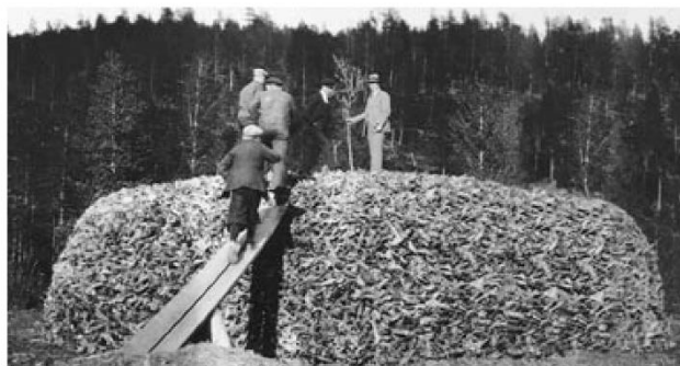
Bygging av tjæremile med hugne tyrirotter – gammelt bilde
