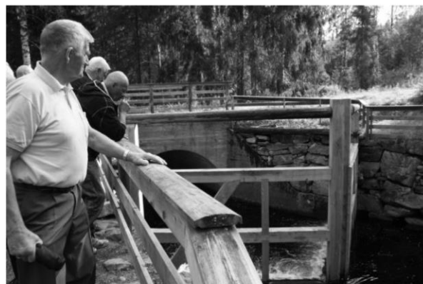
Ved en slusedam. Josef Hansen, Hans Nordseth og Bjørn Engelstad beundrer byggverket.
