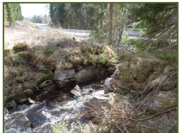
Rester etter gamlebrua over Tveterbekken.
